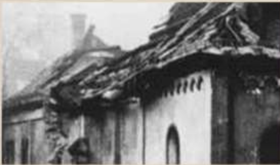
SINAGOGA DI HERZOG A MONACO DI BAVIERA
